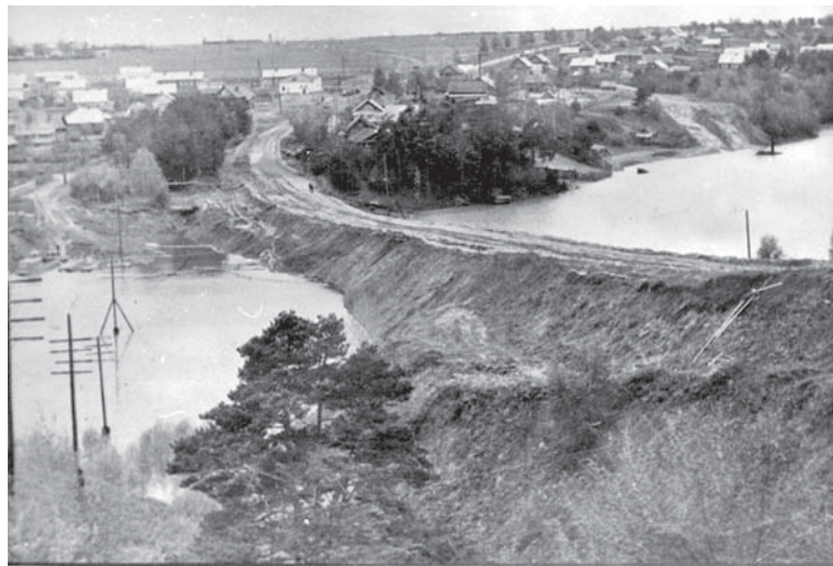
Строительство дамбы с заречной части поселка в нагорную её часть.
